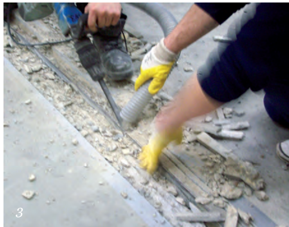
1. Anzeichnen der Begrenzungsschnitte 3. und 4. Erstellung des Fugenbettes
